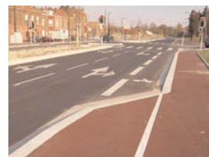
RD 770 Tourcoing : prolongement du boulevard Industriel
