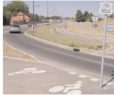
RD 617 Marcy en Barœul : pistes cyclables entre la rocade Nord Ouest et le Pavé Stratégique
