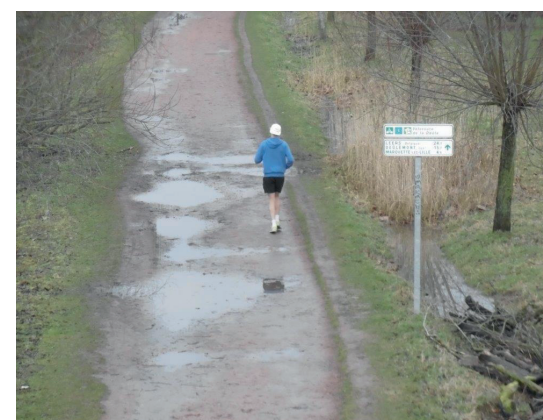
« La réalité de bien des voies vertes qui hébergent une véloroute : flaques, boue... » source : AF3V
